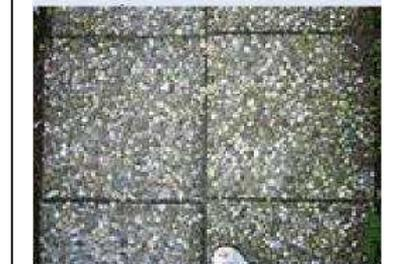
**Betonplatten (ca. 4% Fugen)**
