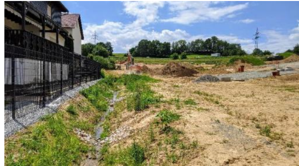
Abbildung 13: Neu ausgebauter Bachabschnitt
