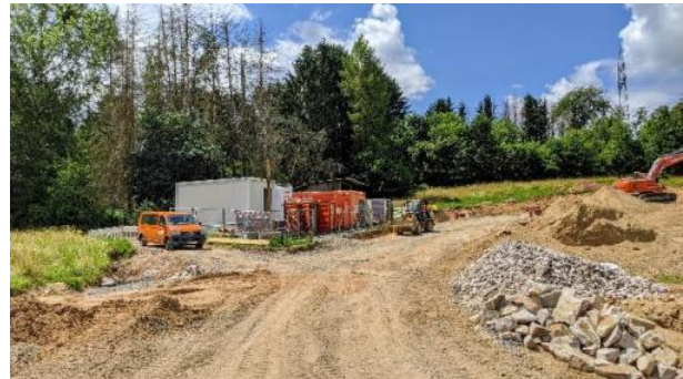
Abbildung 14: Schotterflächen, temporäre Baustelleneinrichtung
