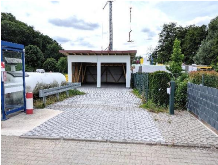
Abbildung 6: Fotodokumentation Garage mit Rasengitterfläche
