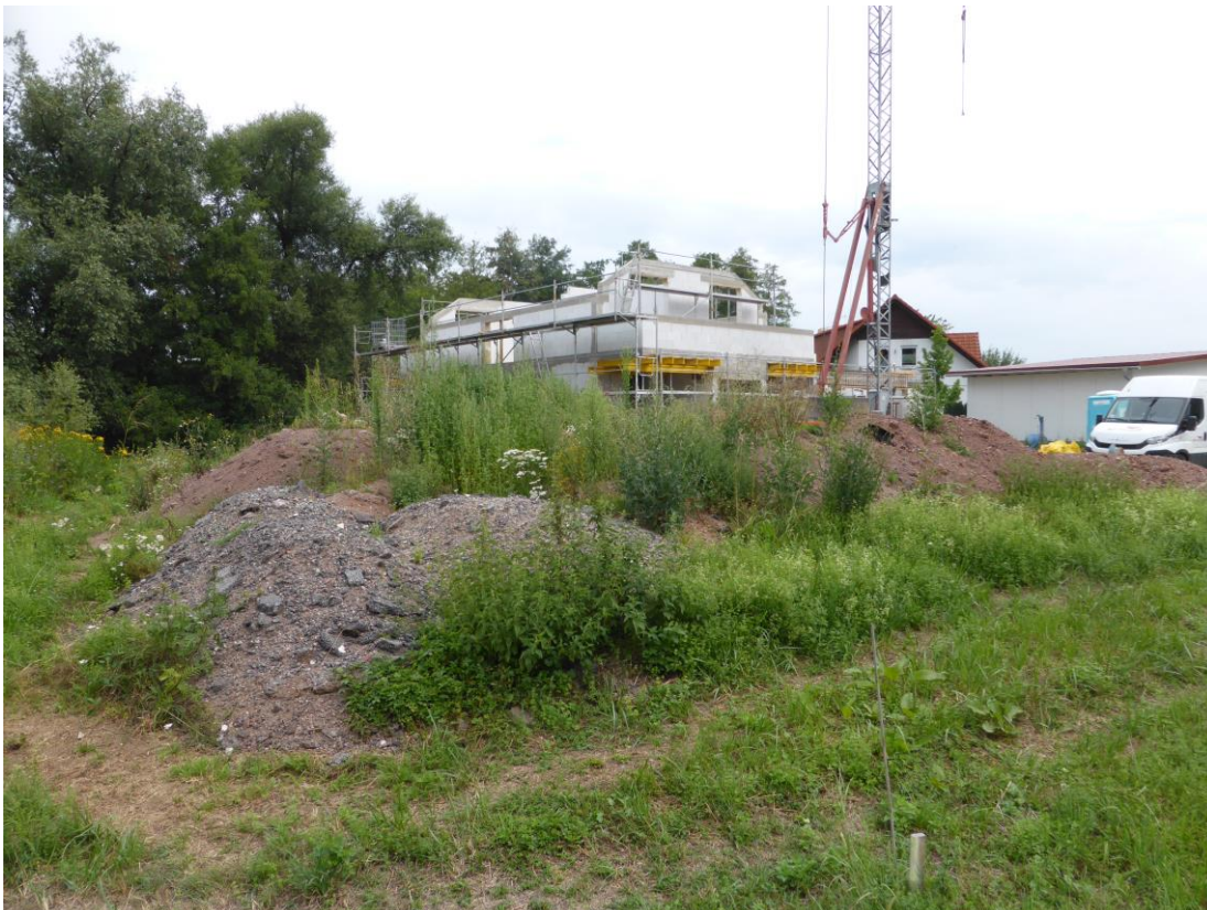
Abb. 4: Baustelle von der B38 aus gesehen
