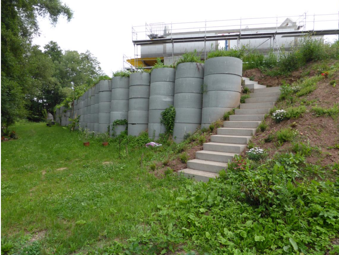
Abb. 5: Befestigung der Böschung zur Weschnitz mit Beton-Kanalrohren
