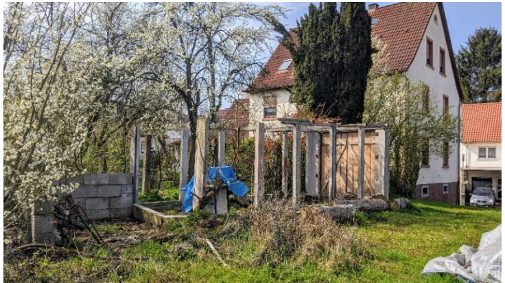
Abbildung 4: Garage im Abbruch begriffen
